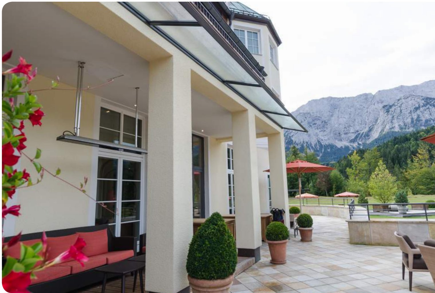
Terrassen-Installation, Schloss Elmau, Krün · Deutschland
