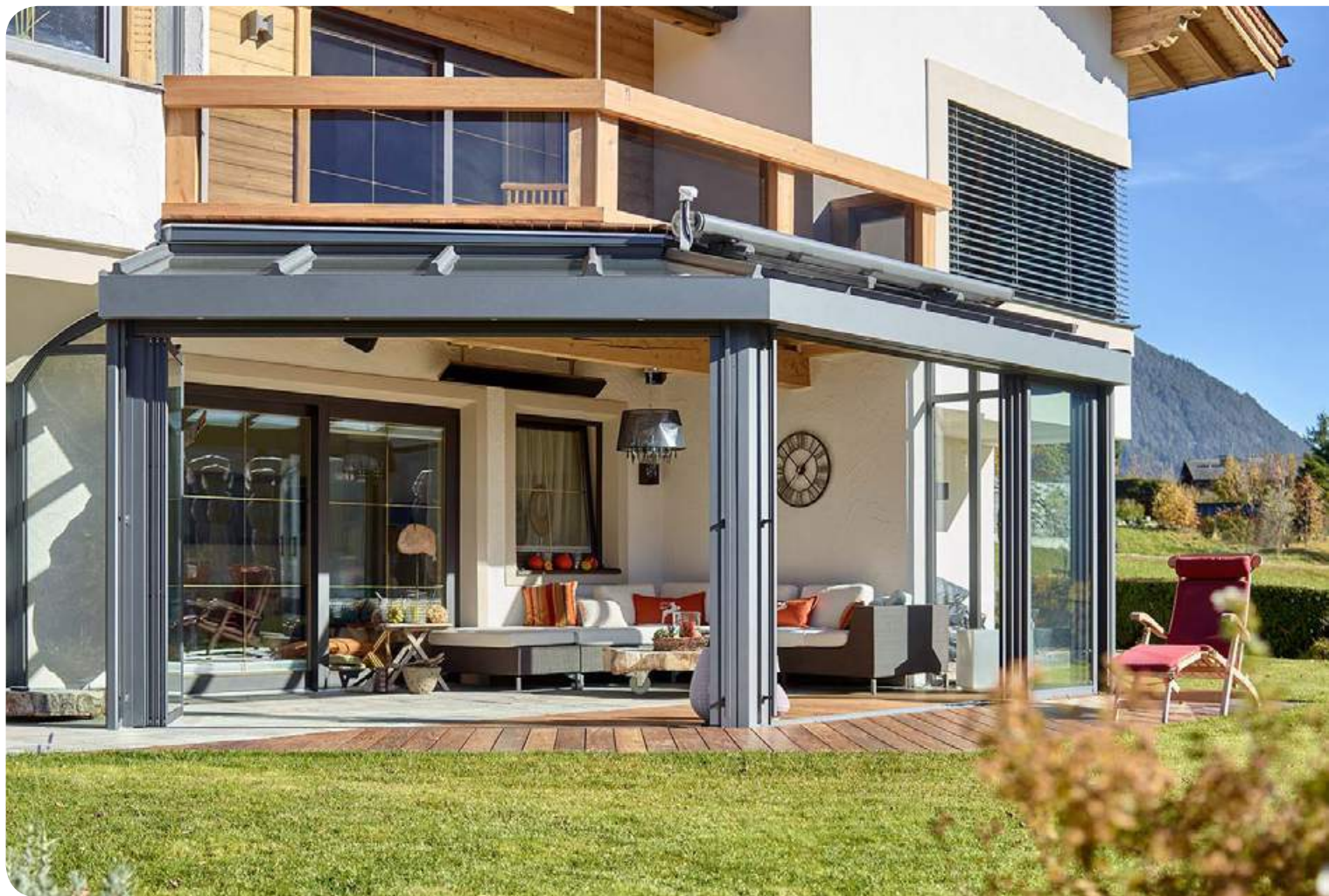
Glashaus-Installation, Achenkirch / Tirol · Österreich
