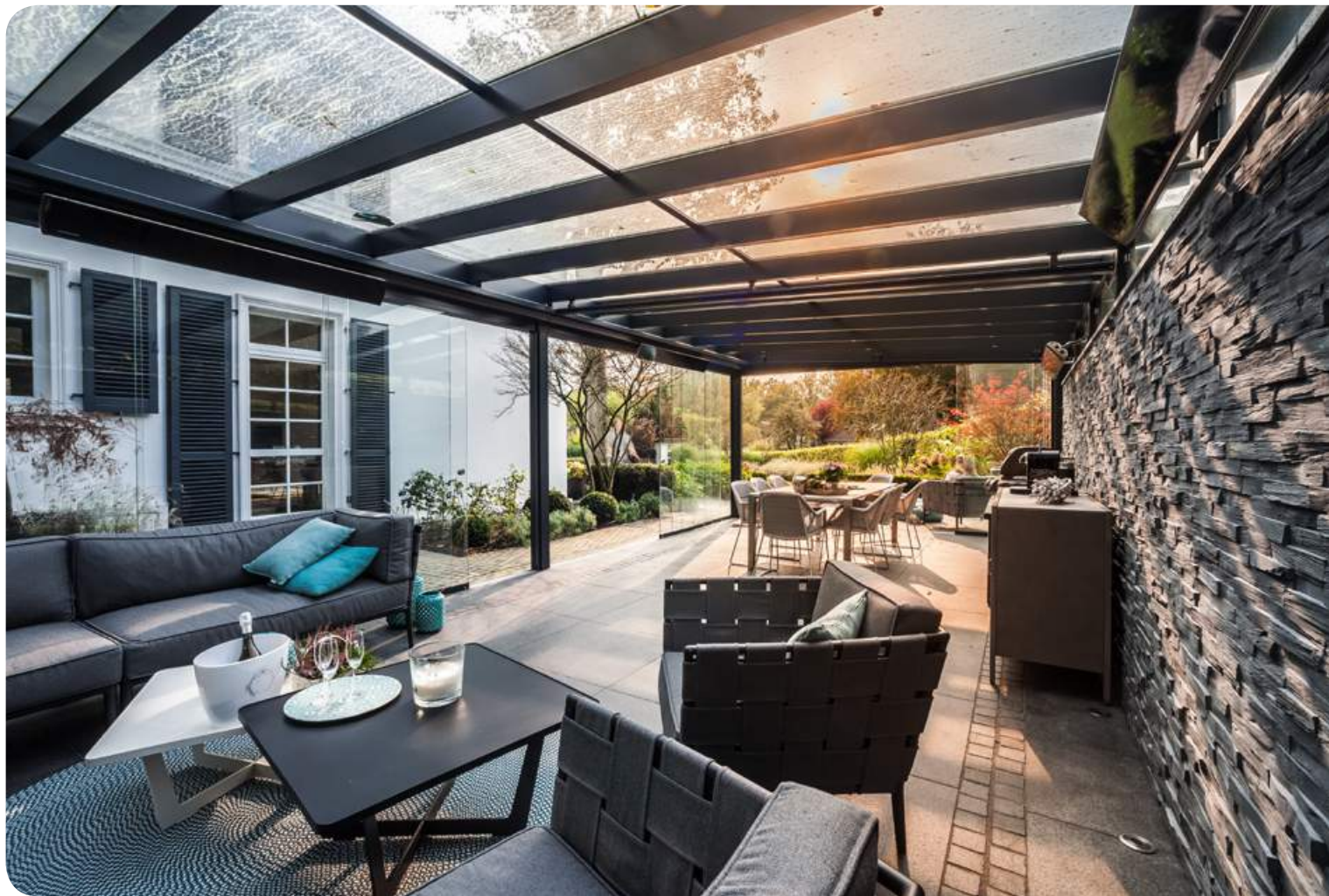
Glashaus-Installation mit Thermostat, Tirol · Österreich
